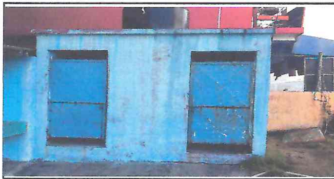
Foto: 5 Sanitarios con Puertas en mal estado, pared en mal estado por falta de repello .
