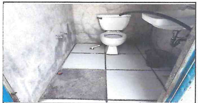
Foto: 6 sanotarios y piso y paraed en mal estado
